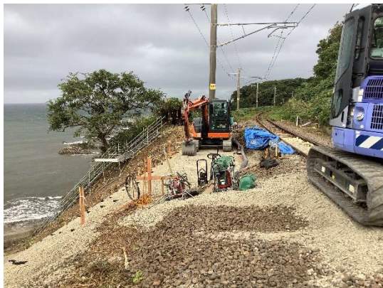
羽越本線 村上駅～間島駅間 被災箇所復旧作業状況 10月2日撮影 (現在、昼夜を問わず復旧作業を実施しています。)
